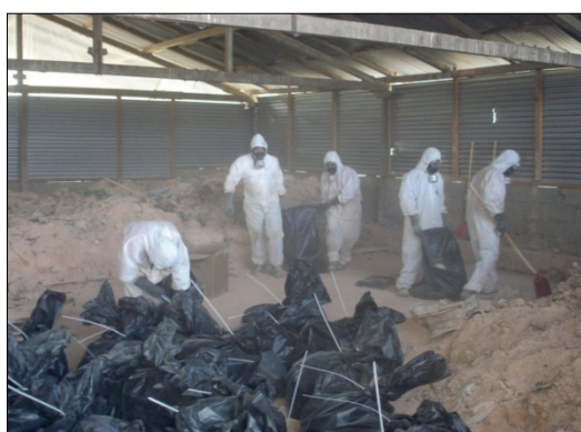
Filling DDTs into black PE bags
